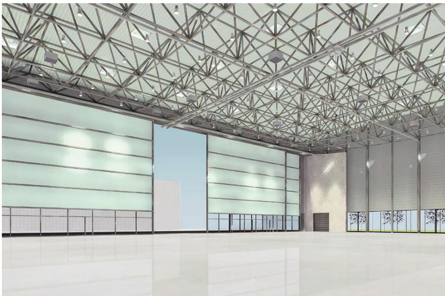
Die sechs Flugzeugstellplätze dienen dem customizing der 728 Jet Linie der Firma Fairchild Dornier, bzw. der Wartung von Flugzeugen bis hin zum Airbus. Die drei Hallenschiffe von jeweils 72x54m und einer lichten Höhe von 19m werden von einem räumlichen Stahlfachwerk überdacht.
