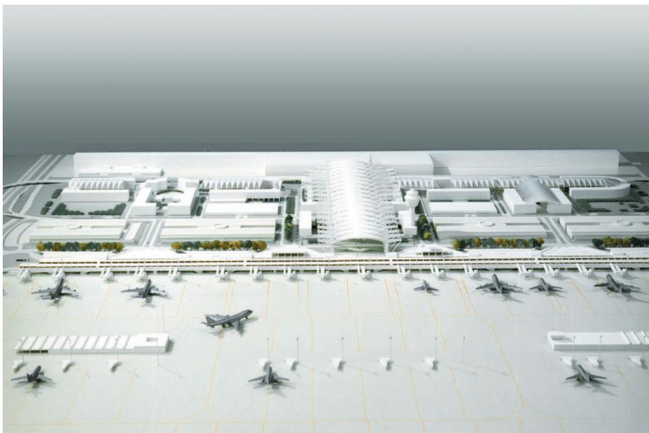
Unter Berücksichtigung der bestehenden Gebäude und Anlagen des Terminals 1 umfasst der Entwurf die Errichtung eines zentral organisierten Terminals 2 (Hauptgebäude und Pier), sowie die zugehörigen Parkgebäude mit den entsprechenden Strassenanbindungen und Vorfahrtsbereichen. Darüber hinaus werden Massnahmen für eine künftige Satellitenanbindung aufgezeigt.
